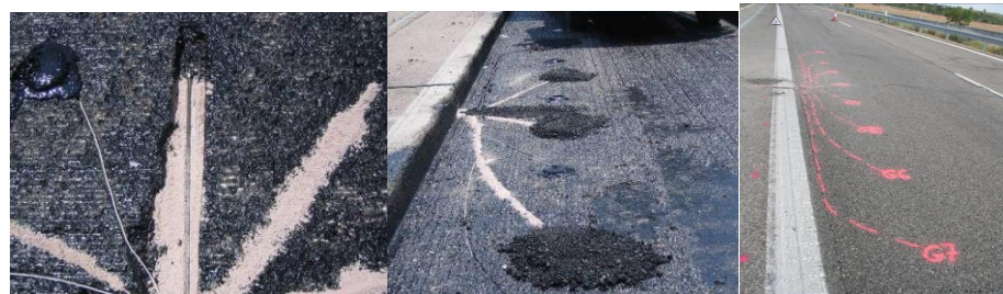
Figura 2 Ejemplo colocación sensórica embebida en firme.
