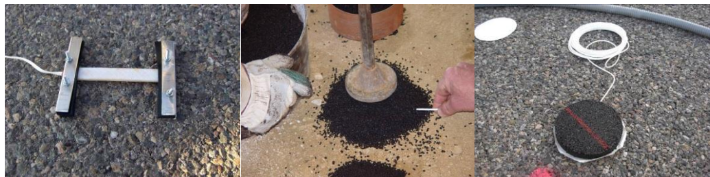
Figura 1 Ejemplo preparación sensórica para colocación embebida en firme (proceso de empastillado).
