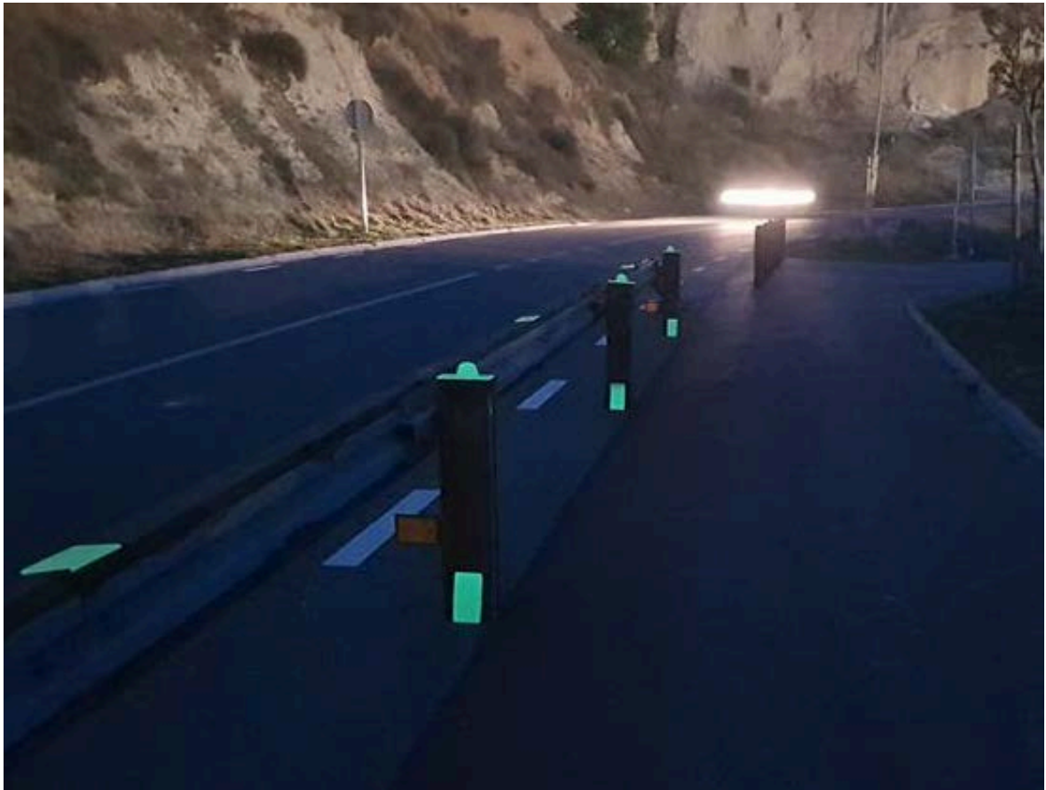
Foto 7. Integración en elemento protector de carril bici-peatonal en carretera local.
