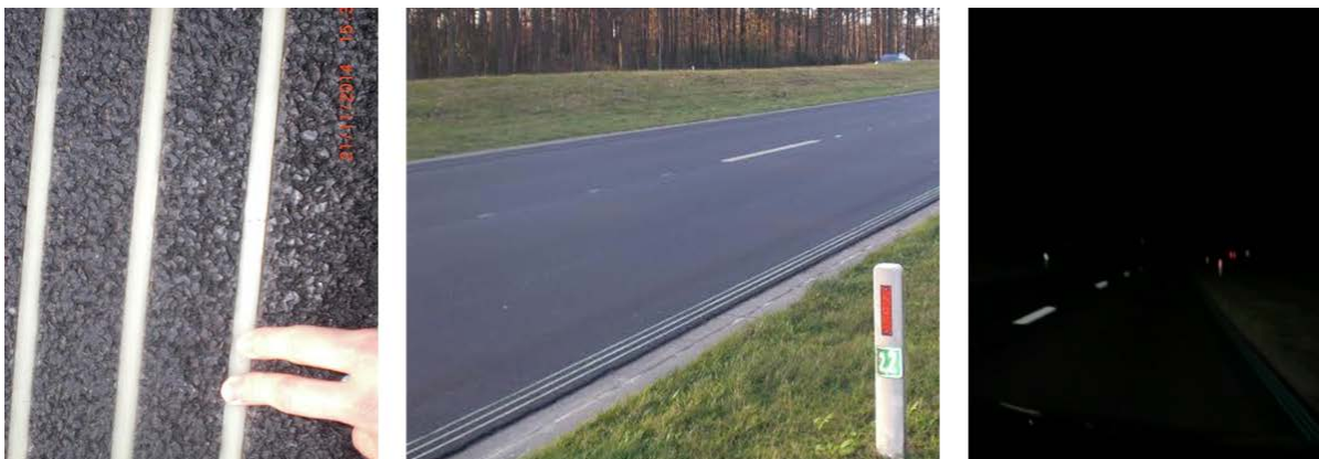
Foto 4 Tramo piloto en Oss N329 (Holanda), noviembre de 2014
