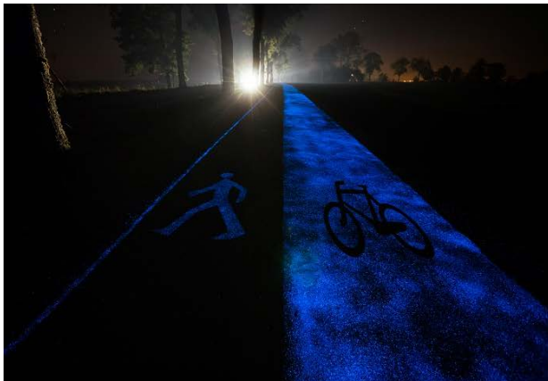
Foto 5 Carril bici en Lidzbark Warminski (Polonia) vs propuesta NIGHTWAY® con losetas UFL Ultrafotoluminiscentes con 2 m de separación.
